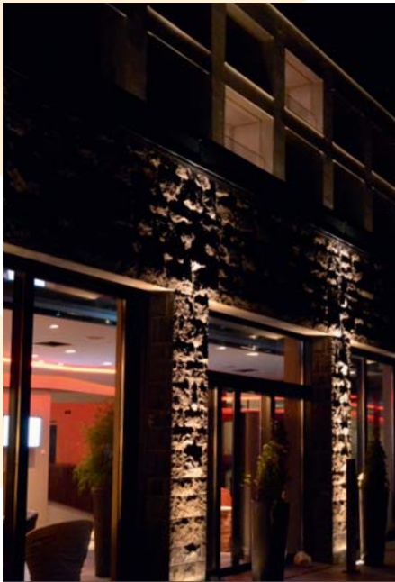
Aussenfassade beleuchtet mit Lichtbändern und Einbau-/ Bodenstrahler mit Schutzart IP68
